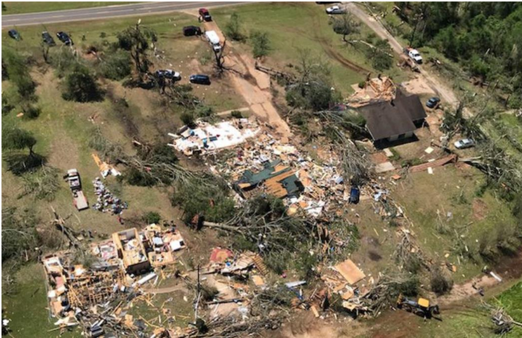
图 3-38: 2019 年 4 月切罗基县住宅遭龙卷风破坏。 234
