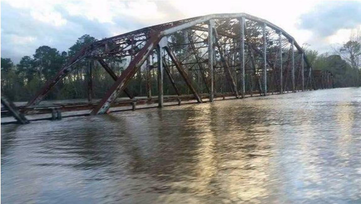
Figura 3-4: Puente Burr's Ferry SH 63 sobre el río Sabine. 11
