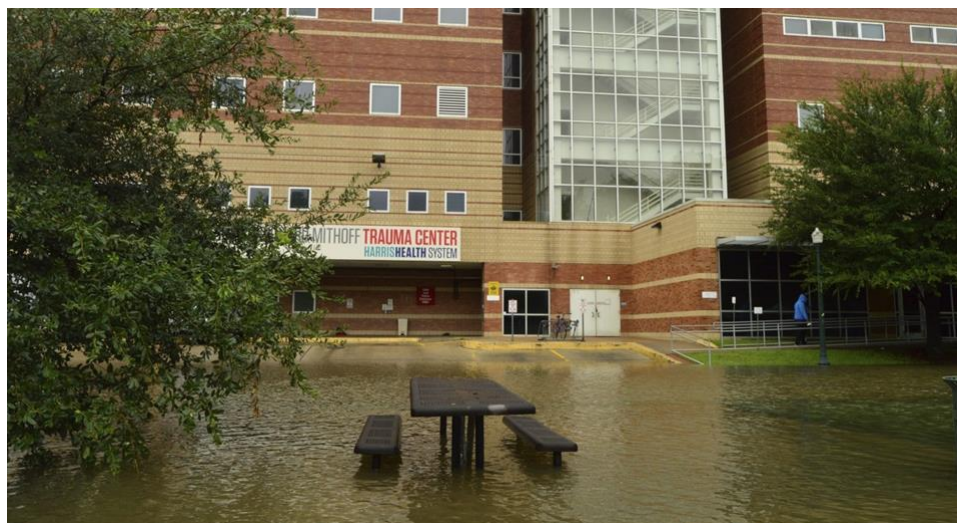
Figura 3-31: Las aguas de inundación del huracán Harvey se aproximan al hospital Ben Taub en Houston. 115
