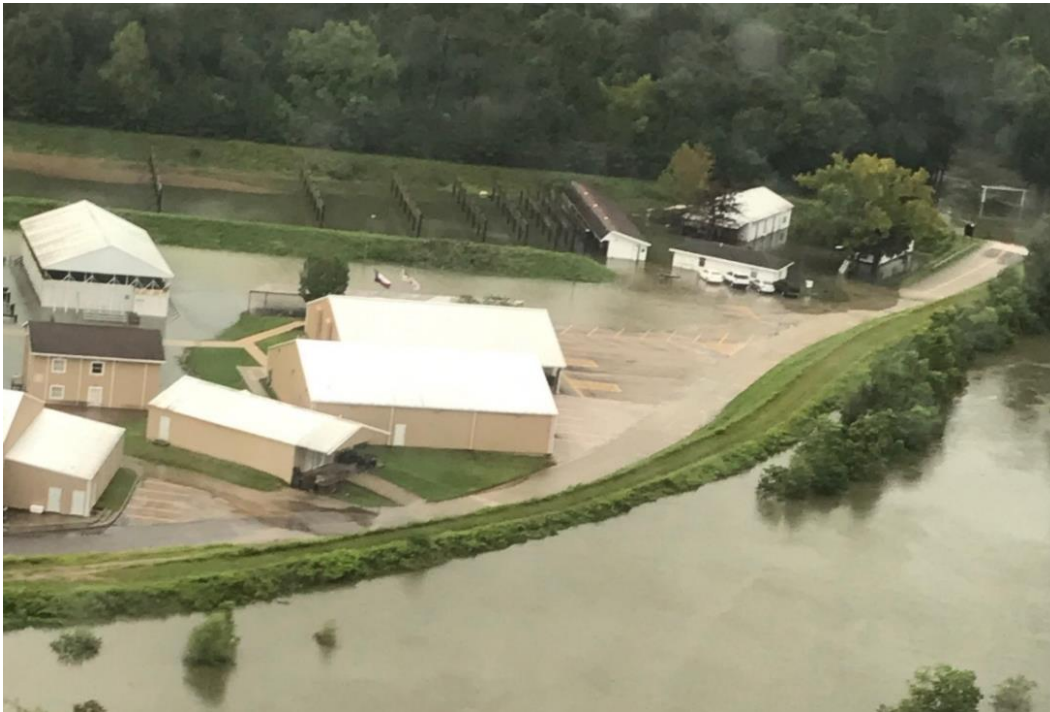
Hình 3-29: Nhà máy xử lý nước thải của thành phố Conroe trong Siêu bão Harvey. 85
