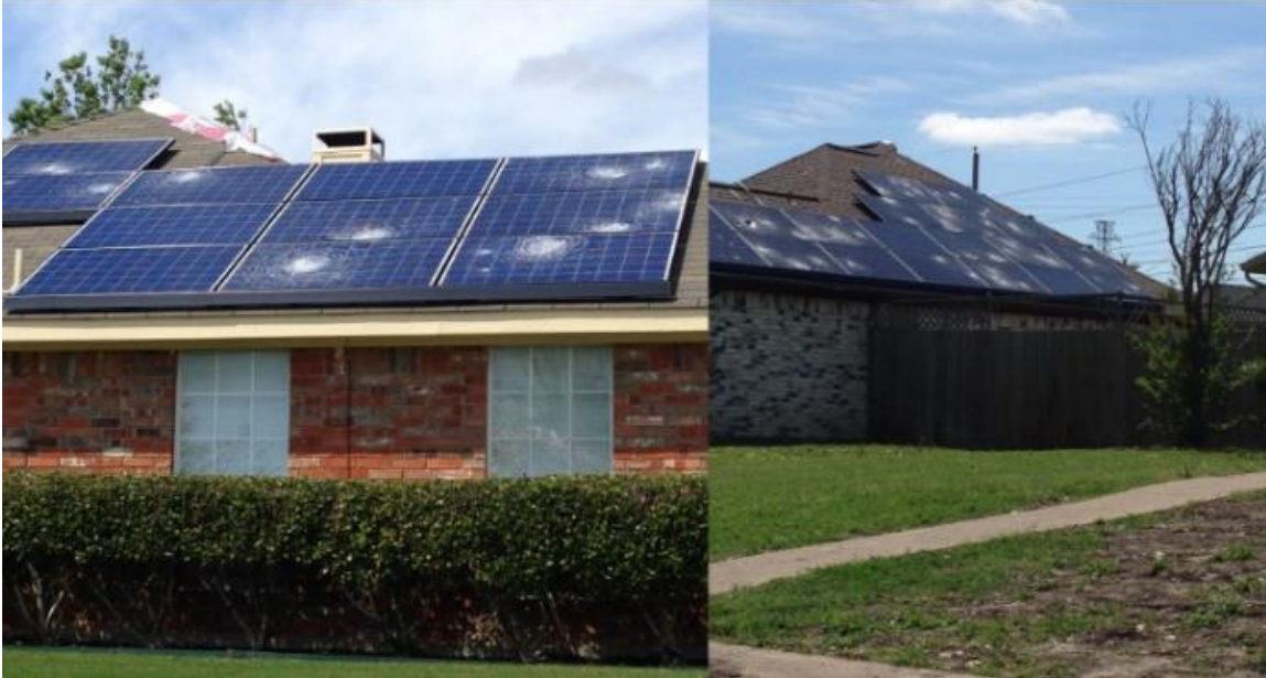
Hình 3-46: Mưa đá gây thiệt hại cho các tấm pin mặt trời dân cư. 216
