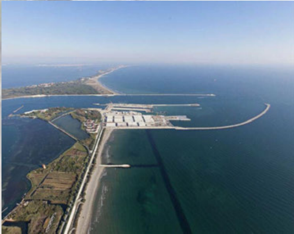
Compuertas contra las mareas de Malamocco, Venecia, Italia
