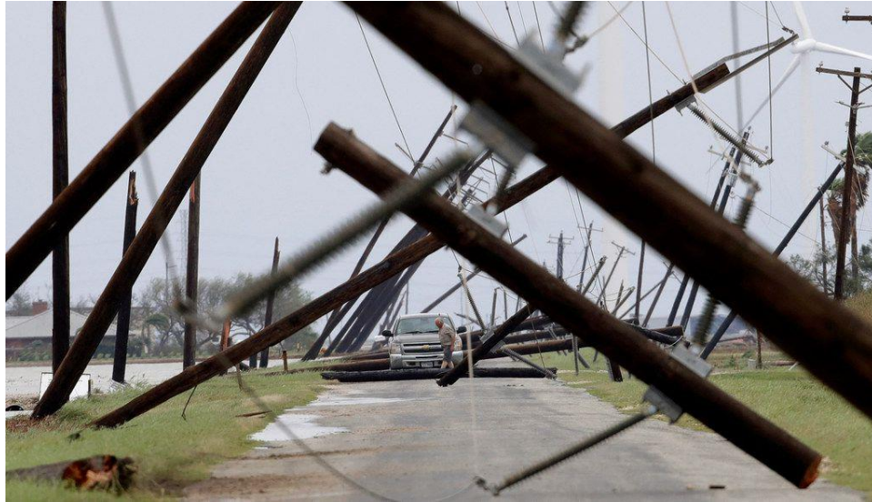
图 2-30: 飓风“哈维”期间，德克萨斯州塔夫特附近被击落的电线。 121
