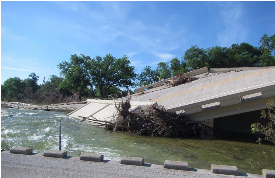
그림 2-1: 블랑코 강 위 Fischer Store Road Bridge. 4
