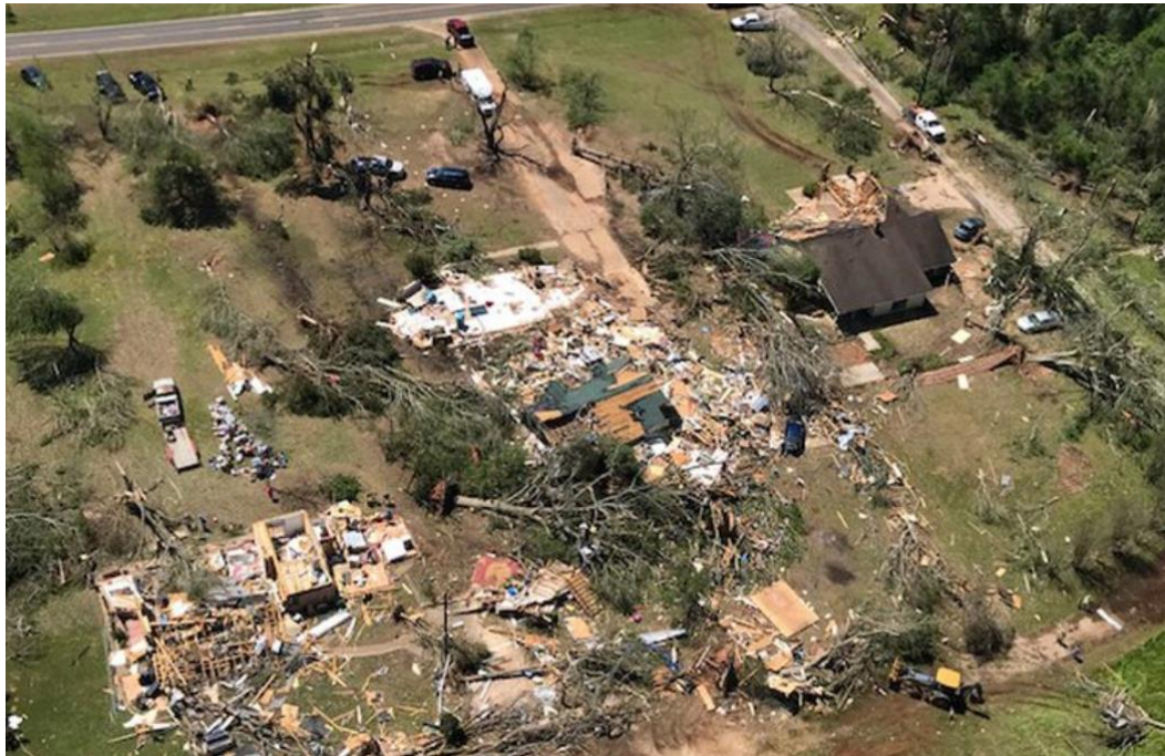
그림 0-46: 2019년 4월에 발생한 토네이도로 인한 체로키 카운티 주거지역 피해. 230
