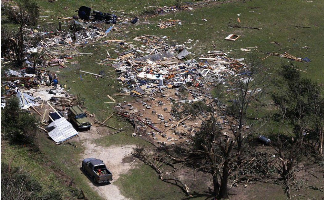
그림 0-47: 2017년 4월에 발생한 토네이도로 파괴된 캔턴의 주택. 233
