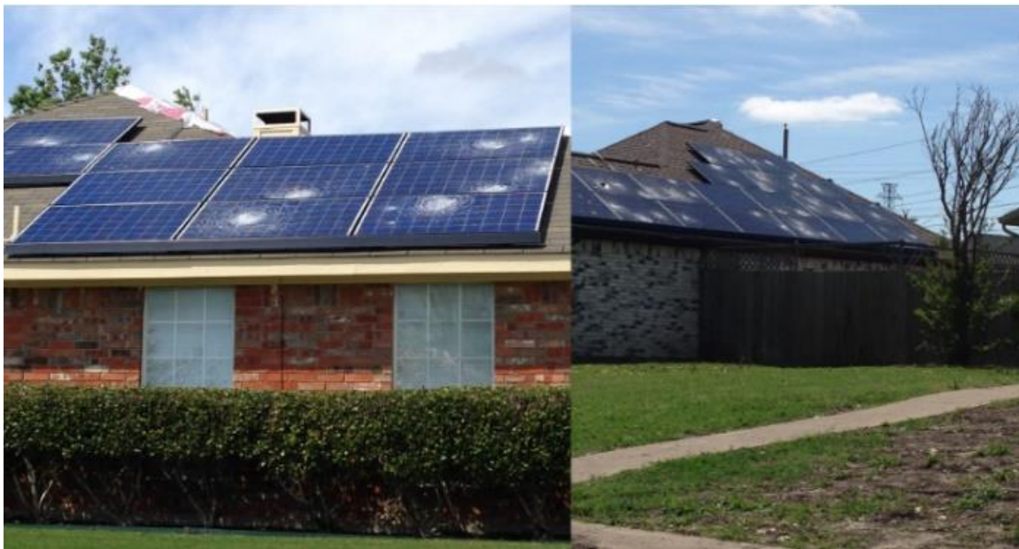
Hình 2-44: Mưa đá gây thiệt hại cho các tấm pin mặt trời dân cư. 213
