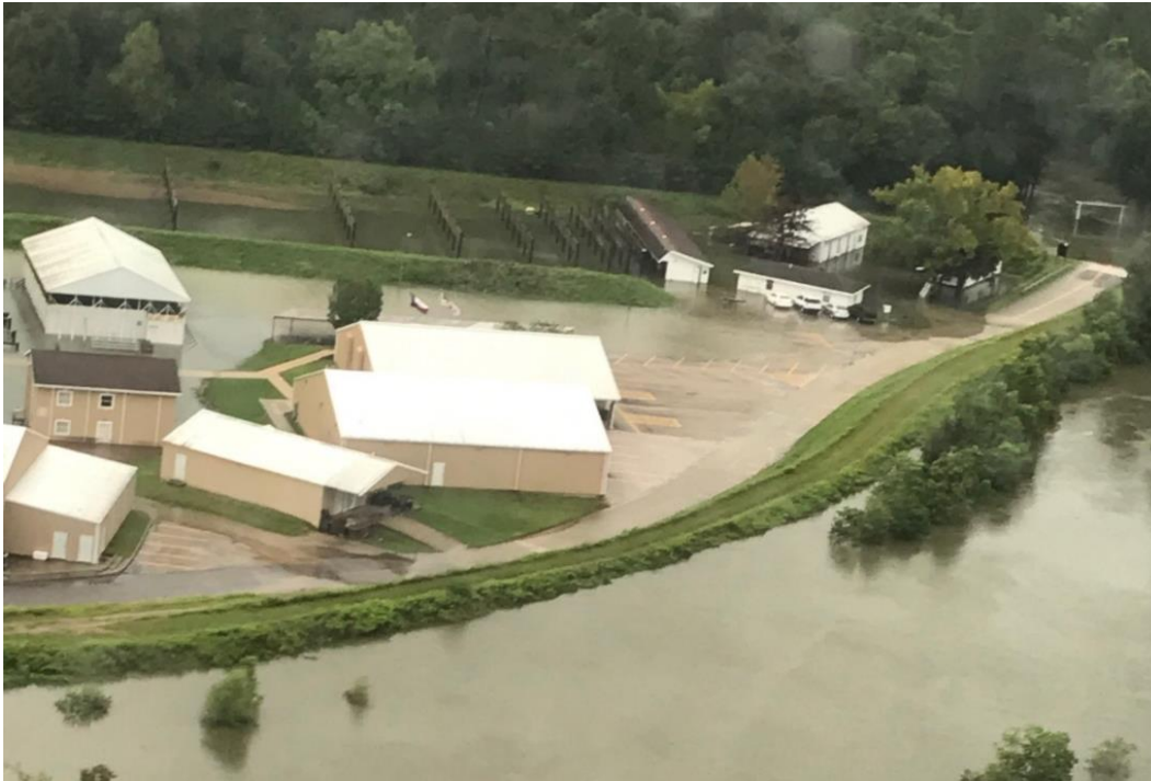
Hình 2-27: Nhà máy xử lý nước thải của thành phố Conroe trong Siêu bão Harvey. 82
