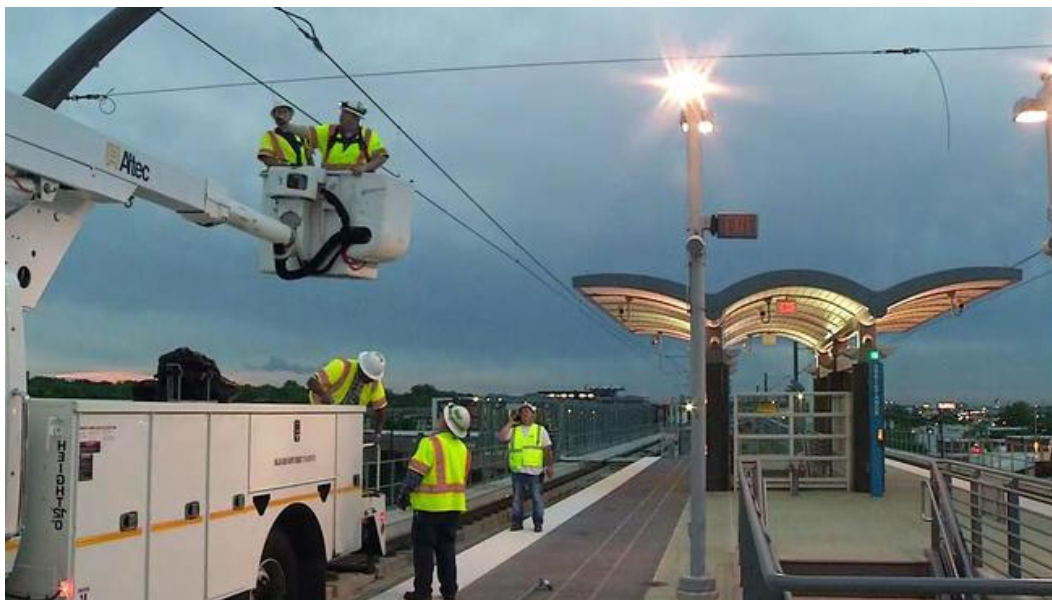
Hình 2-60: Đội bảo trì đang sửa chữa tuyến đường ray Carrollton DART bị hư hại do sét đánh. 342
