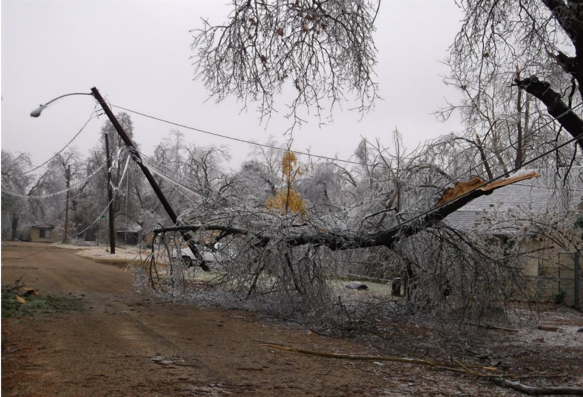
Hình 2-58: Đường dân điện bị rơi trong trận bão băng 2013 ở Paris, Texas. 331
