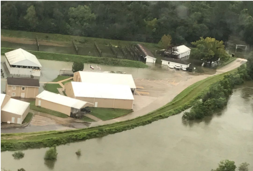
图 3-23: 飓风“哈维”期间康罗市的污水处理厂。 85
