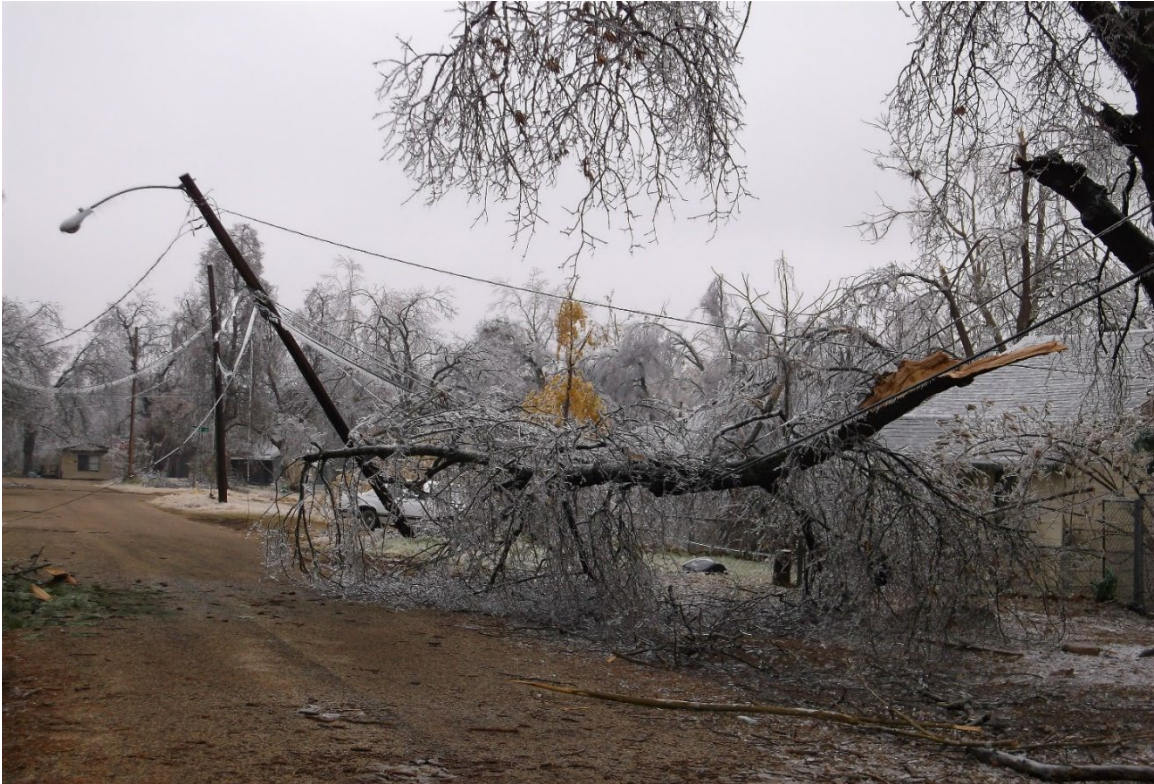
图 3-60: 2013 年德克萨斯州巴黎冰暴期间，电力线倒塌。 334
