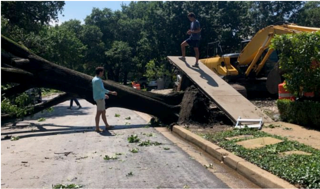
图 3-40: 2019 年 6 月，达拉斯发生雷暴引发的大风，被连根拔起的大树损坏了人行道基础设施，并阻塞了道路。 253
