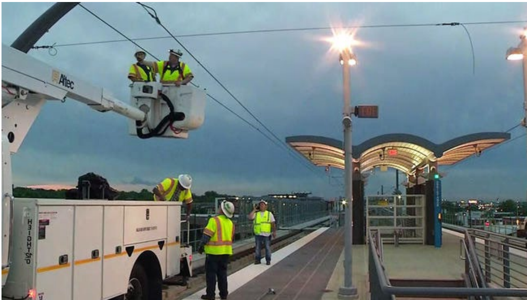
图 3-48: 工作人员正在维修被闪电损坏的卡罗尔顿 DART 站铁路。 345
