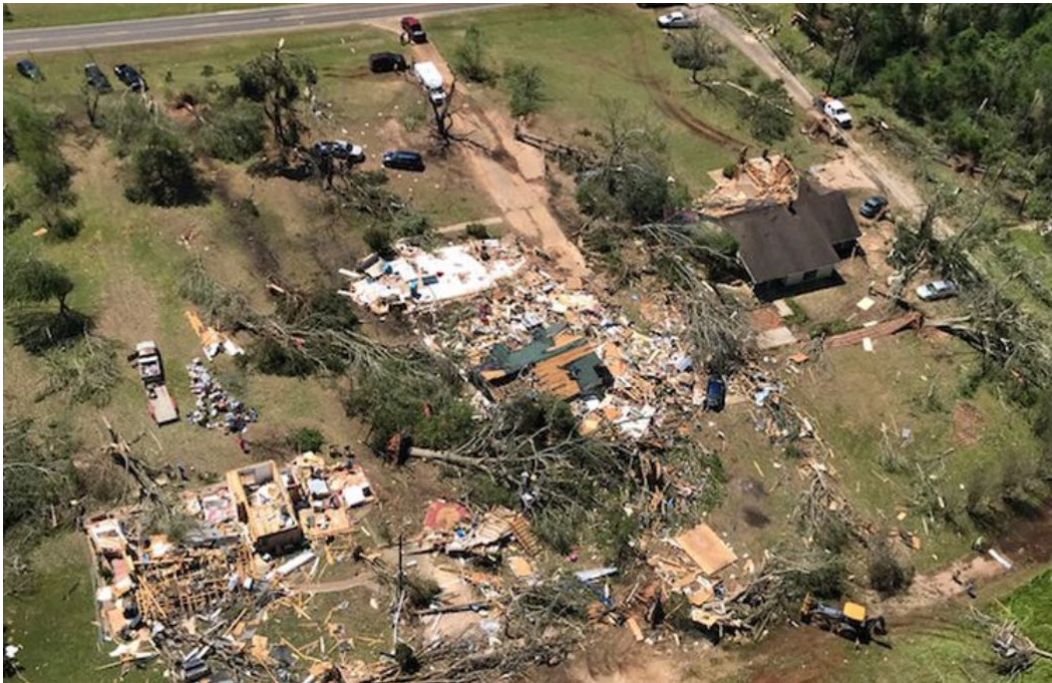
图 3-38: 2019 年 4 月切罗基县住宅遭龙卷风破坏。 234
