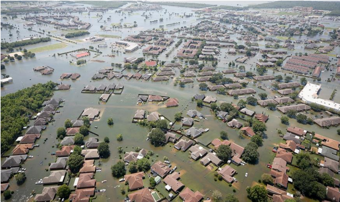
Figura 3-28: Inundación en Port Arthur, Texas, durante el huracán Harvey. 75
