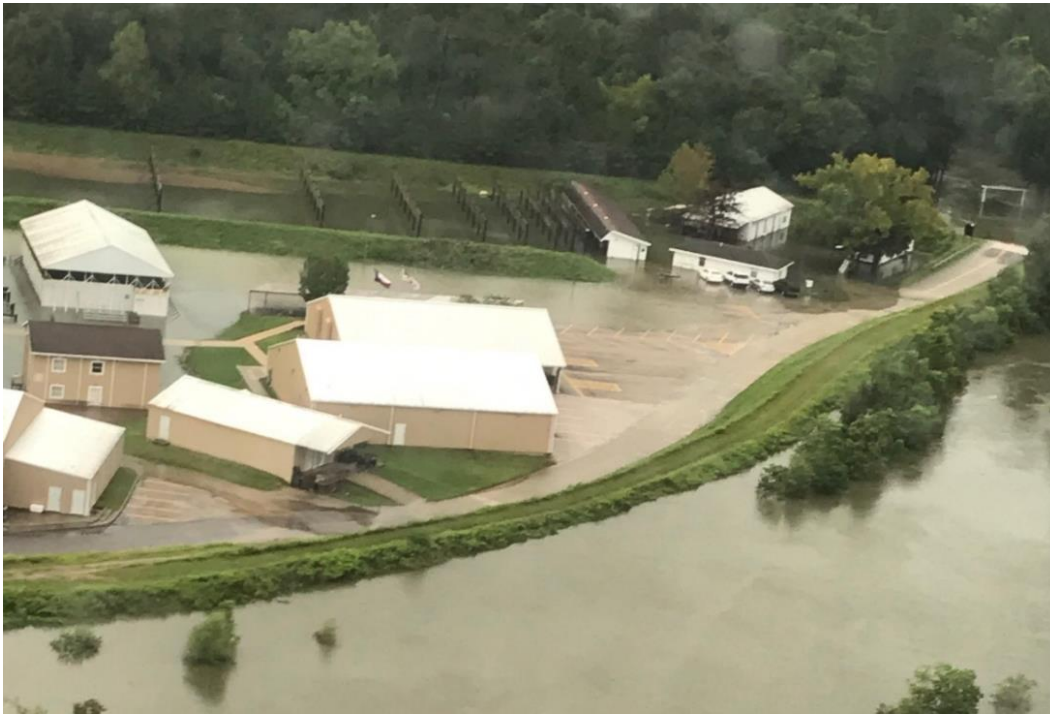
Figura 3-29: Planta de tratamiento de aguas residuales de la ciudad de Conroe durante el huracán Harvey. 85
