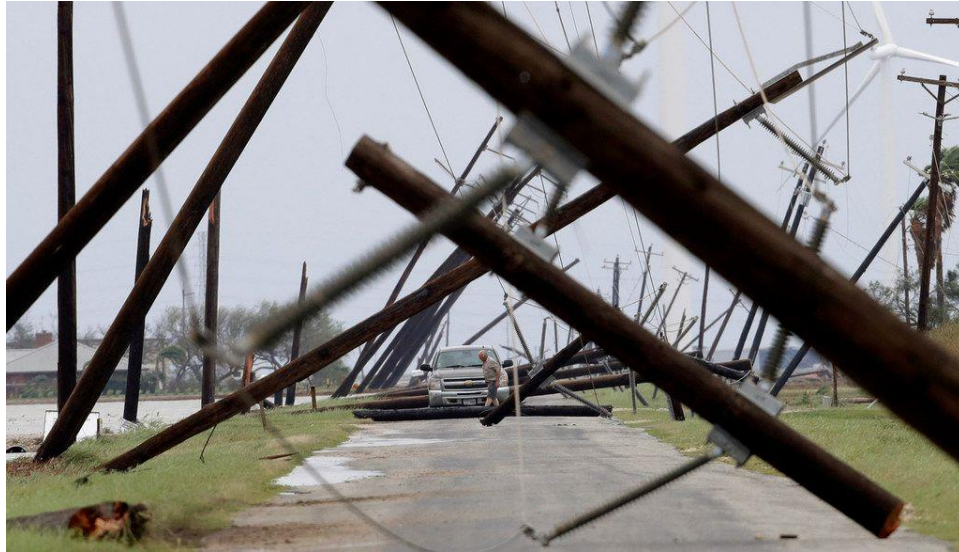
Figura 3-32: Líneas de energía derribadas cerca de Taft, Texas, durante el huracán Harvey. 125
