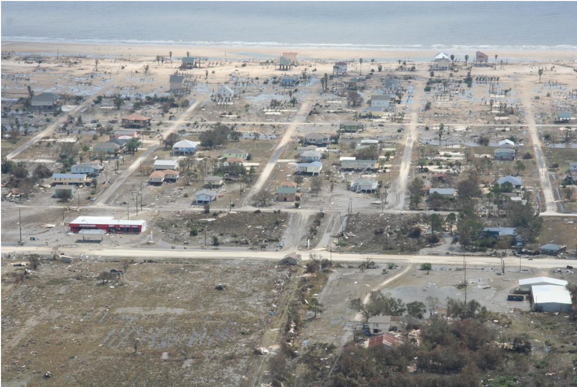
Figura 3-27: Península de Bolivar, Texas, después del huracán Ike. 70
