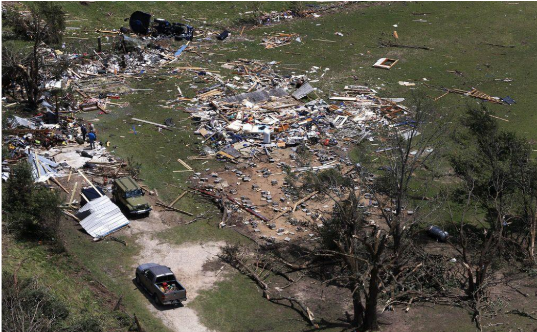
Figura 3-49: Vivienda destruida en Canton, tornados de abril de 2017. 237
