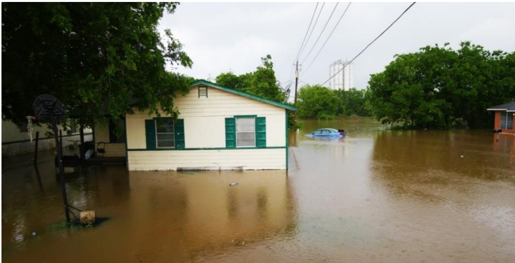
Figura 3-37: Viviendas inundadas en Wharton durante las inundaciones de 2016. 148
